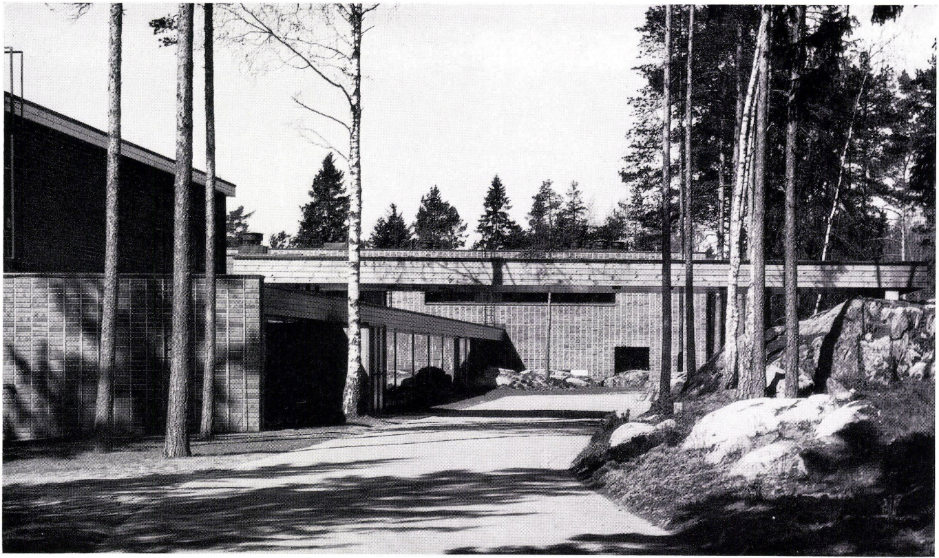
Hauptzufahrt auf der Nordseite der Hauptgebäude. Accès automobile principal sur la face nord des bâtiments principaux. Main car approach to northern façade of main buildings.
