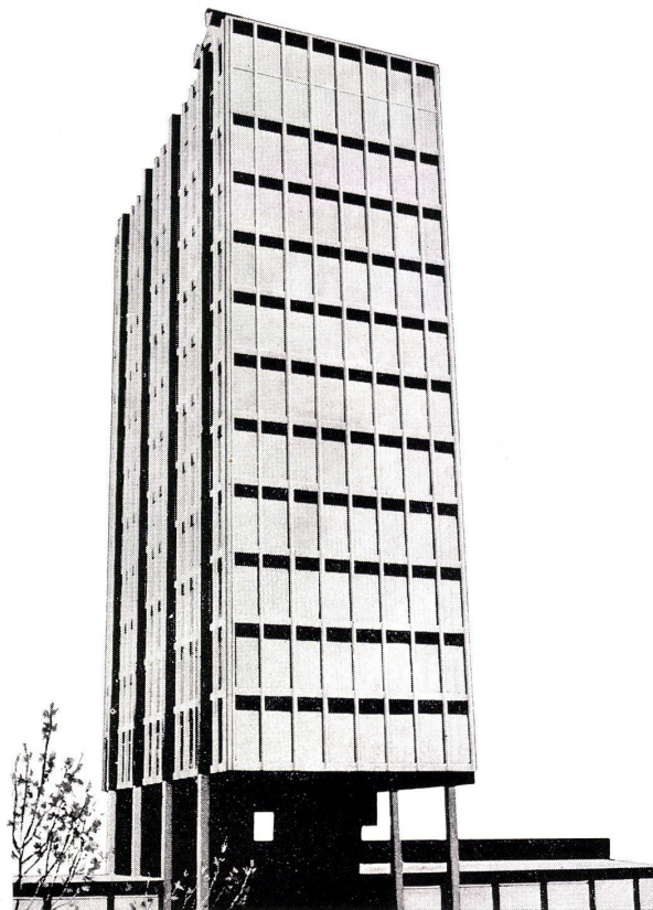
Imprimeries Réunies - Lausanne. Architekt: J.-M. Lamunière
