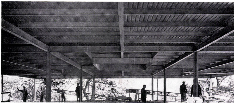
1 Dachkonstruktion mit Untersicht der Tektalelemente, bestehend aus Sickenblech und Rippe. Construction de toiture avec éléments de tektal, se composant de tôle et nervures. Roof construction with tektal-elements, consisting of sheet metal and corrugated roofing.
