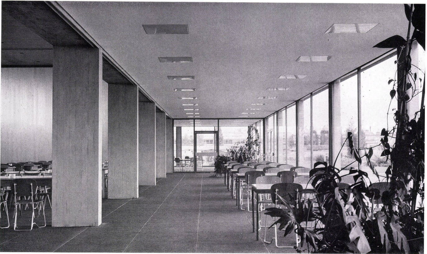
1 Das Seitenschiff des großen Speisesaals. Dunkle Waschbetonplatten bilden den Bodenbelag. Partie latérale de la grande salle à manger. Les sols sont revêtus de plaques en béton lavé foncées. The side aisle of the large dining hall. Dark washed concrete slabs on the floor.
