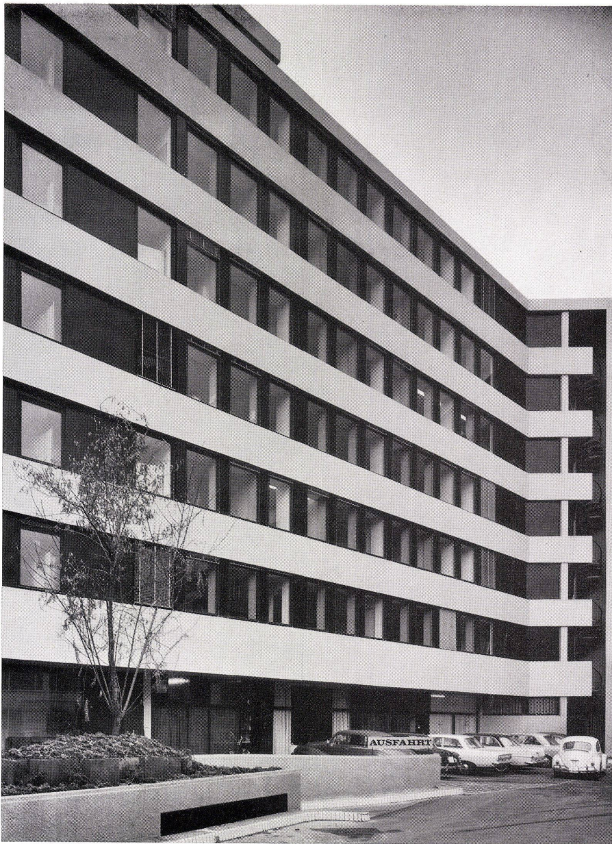
1 Hoffassade. Façade côté cour. Courtyard elevation.
