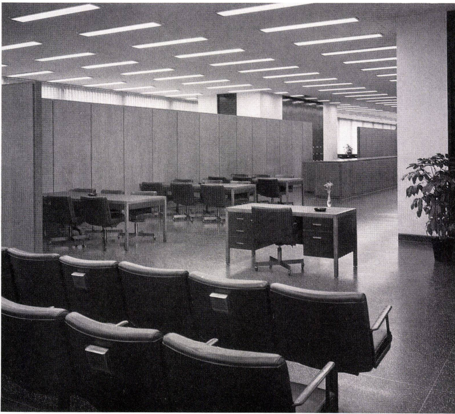
1 Ein Vortragssaal im 17. Geschoß. Bodenmaterial: Vinyl-Asbestplatten, Schreinerarbeit in Eiche. Salle de conférence au 17ème étage. Revêtement de sol: asbeste de vinyl. Bois de chêne pour le reste. A lecture hall on the 17th floor. Flooring: Vinyl asbestos tiles, woodwork of oak.
