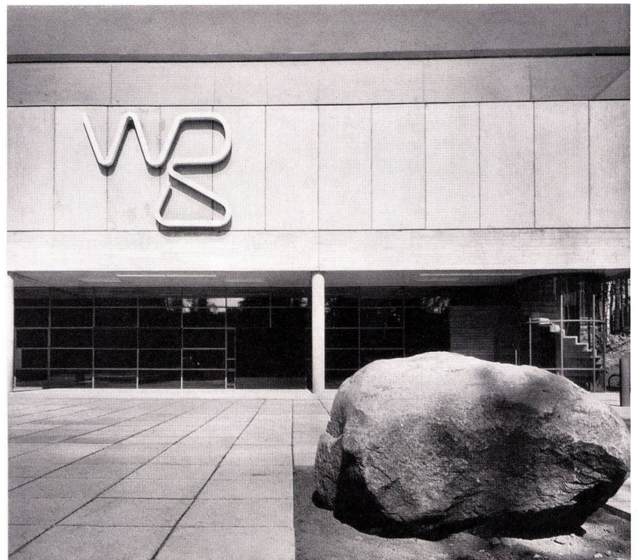
4 Eingang mit Firmenzeichen. Die Produktionshalle hat auf drei Seiten nur ein Fensterband unter der Decke. Entrée avec raison sociale. La halle de production n'a qu'une fenêtre sur trois côtés, sous la dalle supérieure. Entrance with firm designation. The production shed on three sides has only one window strip, under ceiling.
