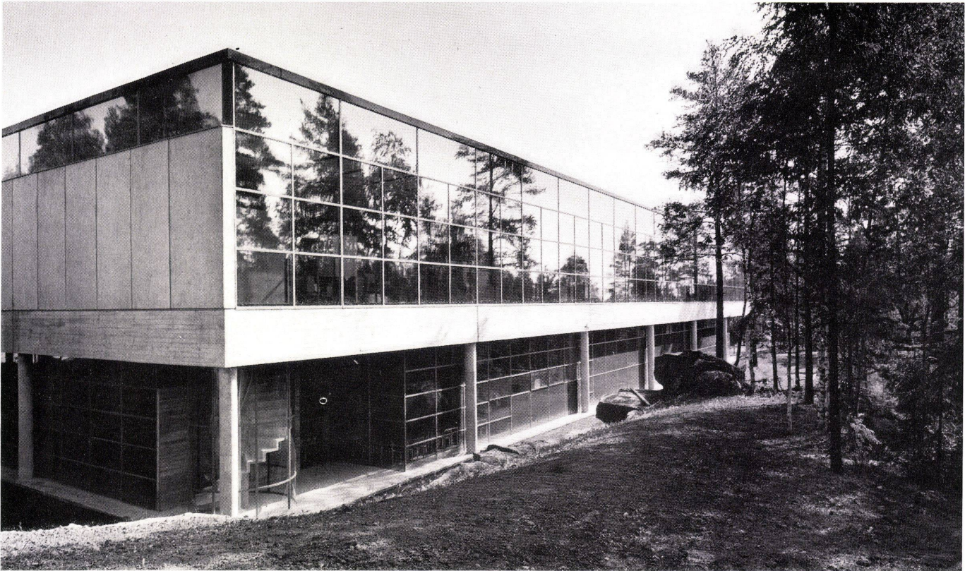
1 Nordwestfassade mit dem großen Aussichtsfenster in der Produktionshalle, links wird eine der Flucht- treppen sichtbar. Façade nord-ouest avec grande baie vitrée dans la halle de production. A gauche, un escalier de se- cours. Northwest face with the large window in the pro- duction shed, left, one of the emergency stairs.
