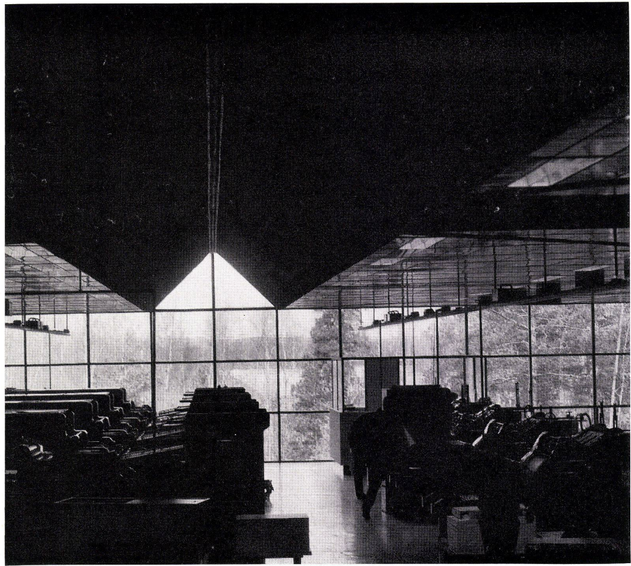
2 Blick aus der Produktionshalle gegen Nordwesten. Über dieser Halle liegt ein an vier Türmen aufgehängtes Dach von ca. 150 Meter Konstruktionshöhe. Diese Höhe wird spürbar an den Außenkanten des Raumes und bei den Dilatationsfugen zwischen den vier Grundrißteilen.
