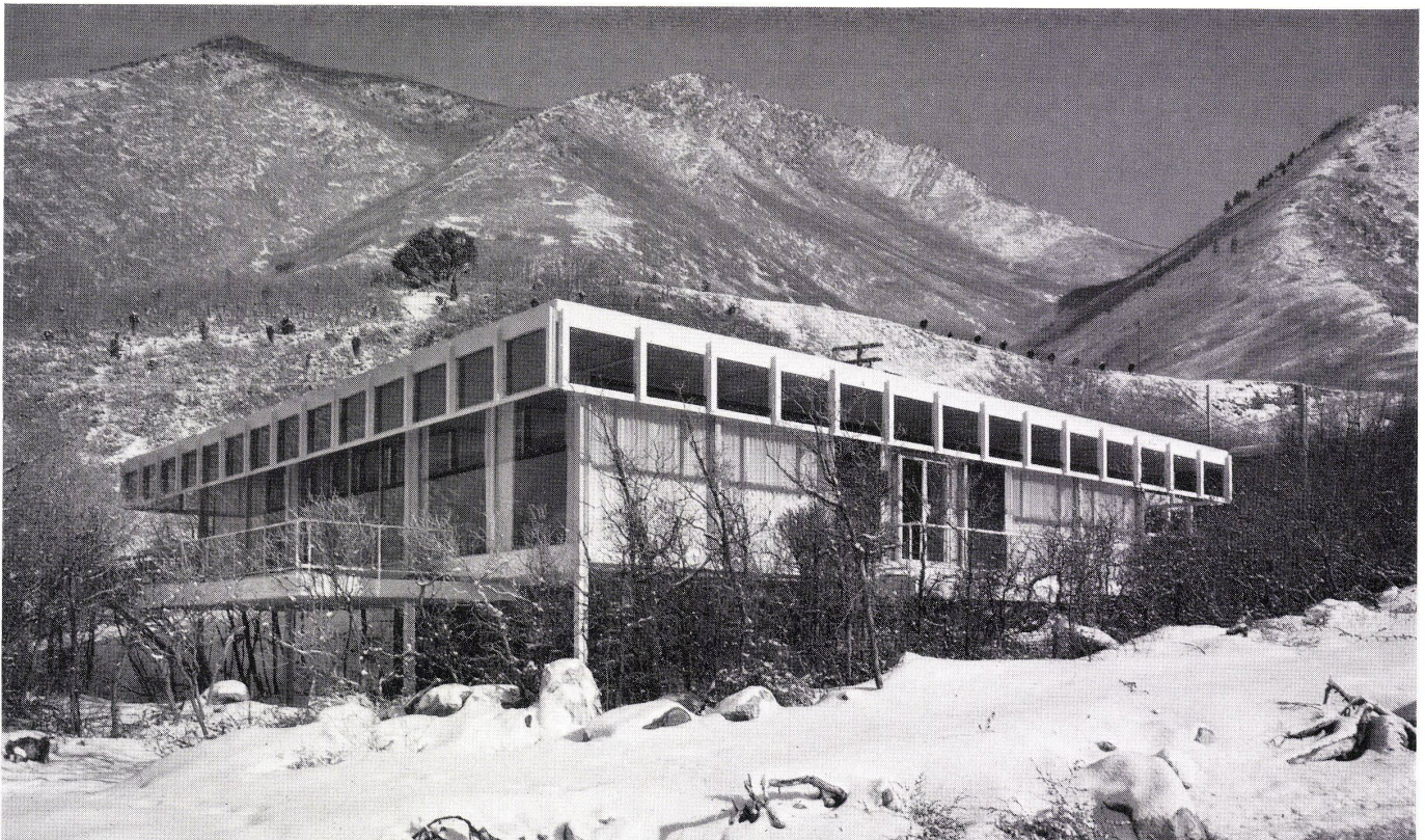
3 Südwestansicht. Vue sud-ouest. Southwest view.
