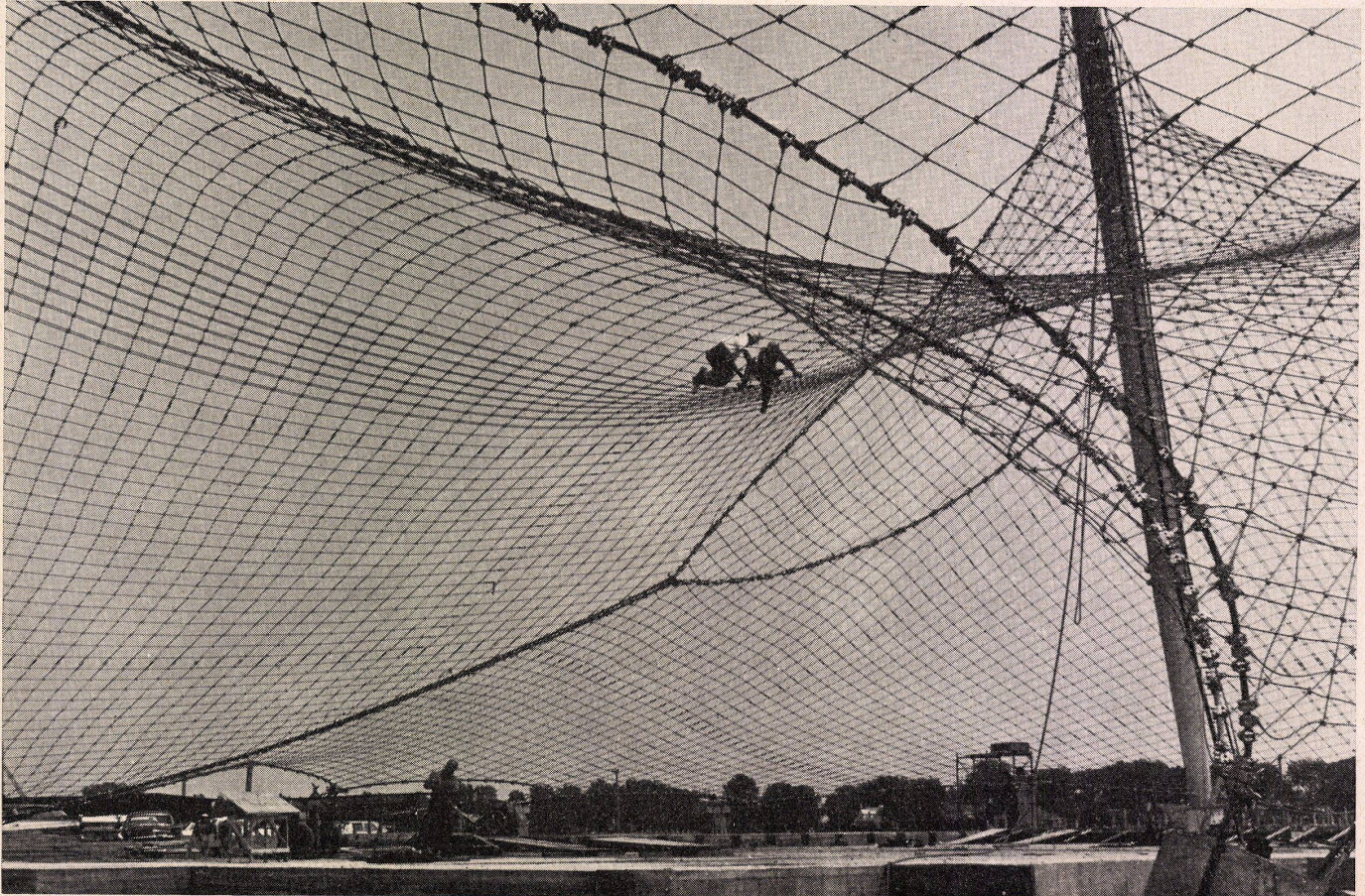
27 Spannungskontrolle am Netz. Contrôle de tension du filet. Tension check on the net.
