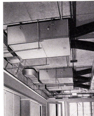
3 Zweikanal-Hochdruck-Klimaanlage mit Mischgeräten. 4 Einkanal-Hochdruck-Klimaanlage mit Entspannungsgeräten. 5 An der Flurdecke angeordnete Mischgeräte.
