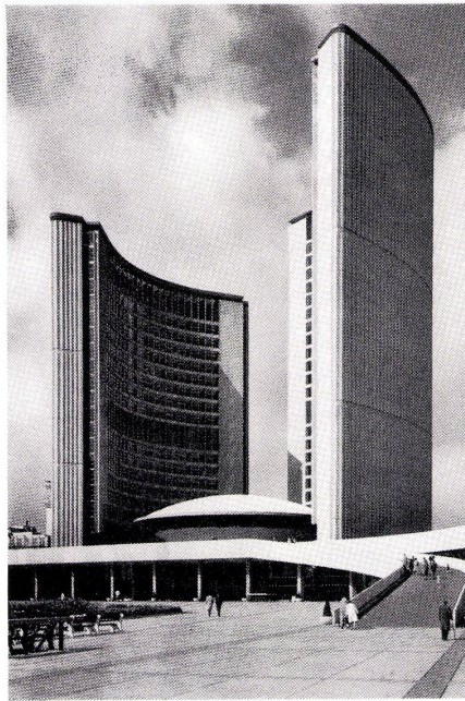
2 Hochhausscheiben des neuen Rathauses in Toronto. Vitres de la maison-tour du nouveau «Town Hall» à Toronto. High-rise segments of the new Town Hall in Toronto.
