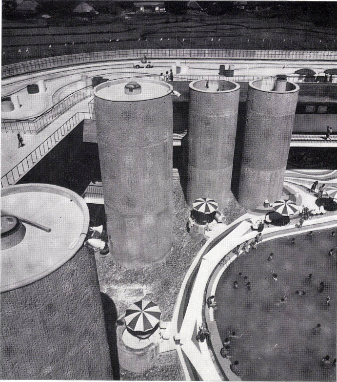
6 Die Türme enthalten Treppen (links) und Toiletten (rechts). Les tours renferment des escaliers (à gauche) et des toilettes (à droite). The towers contain stairs (left) and toilets (right).
