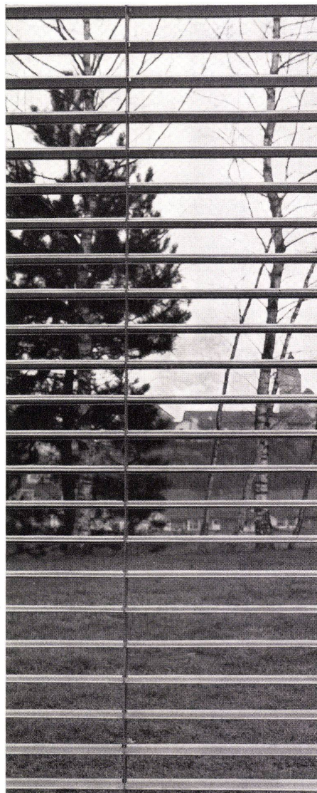
Typ 80, randgebördelte Lamellen, weite Rasterbildung mit Horizontalbetonung. Bessere, unbehinderte Sicht von innen nach aussen.
