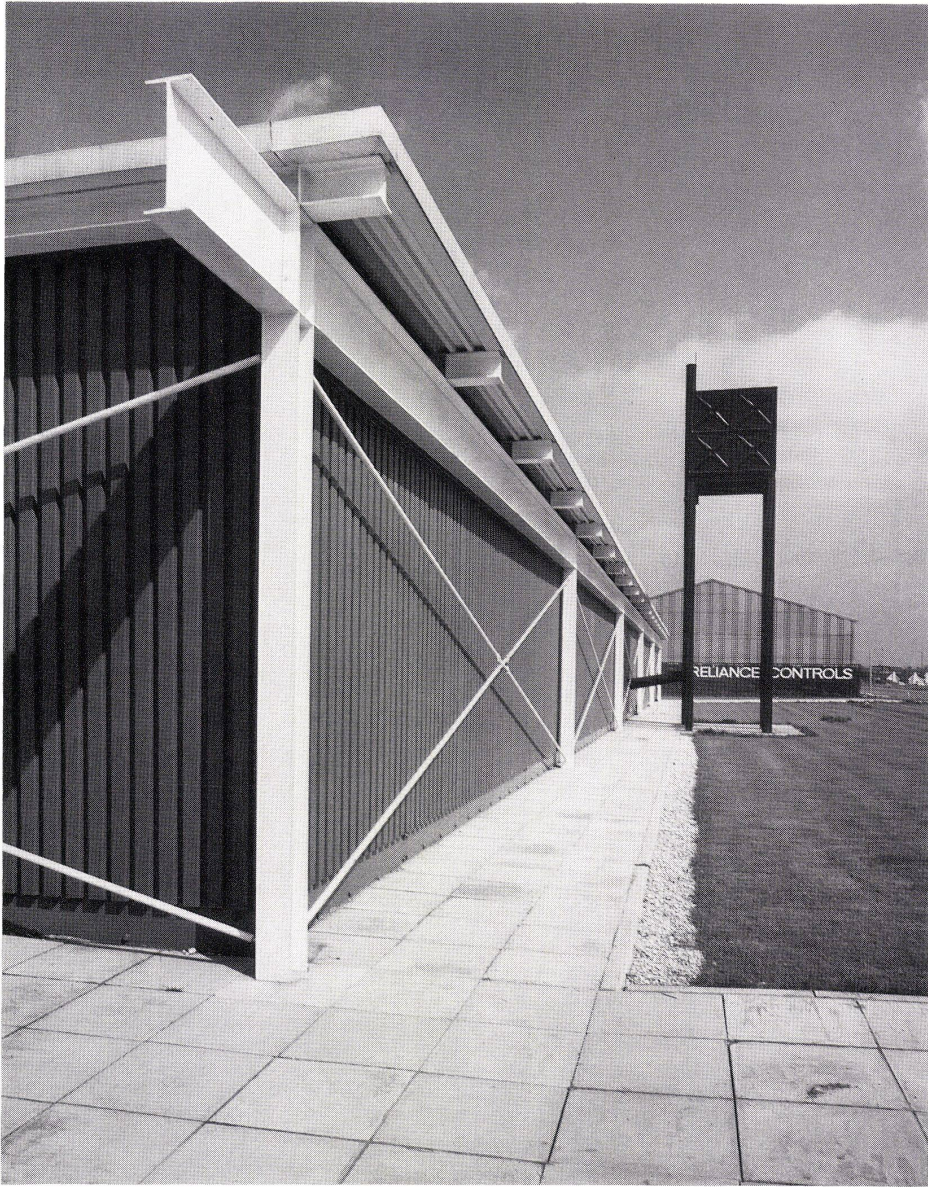
14 Ansicht, rechts der Wasserhochbehälter. Vue, à droite le haut réservoir d'eau. Elevation view, right, the elevated water tank.
