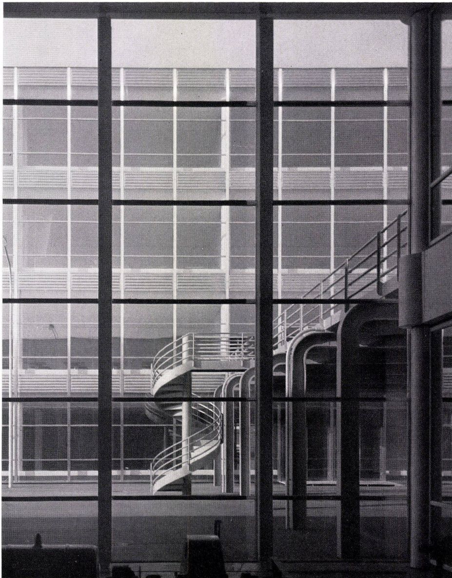
47 Verbindungsbrücke mit Wendeltreppe von der Ma- schinenhalle aus gesehen. Pont de liaison avec escalier en colimaçon vu depuis le hall des machines. Connecting bridge with spiral stairs from machinery shed.
