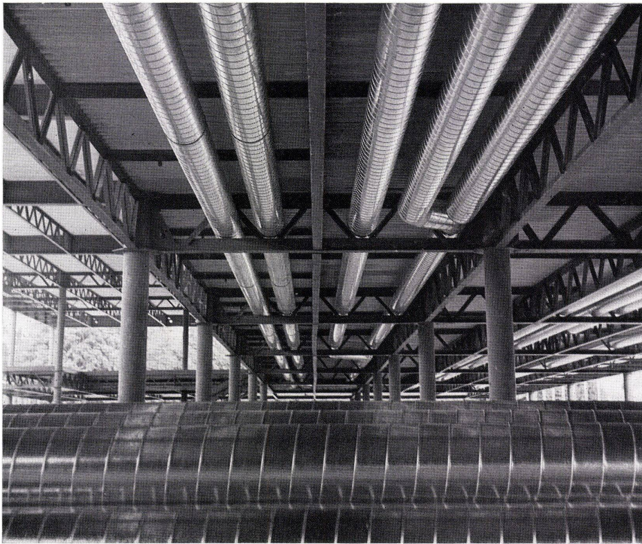
21 Einbau der Luftkanäle für die Klimaanlage. Installation des canaux d'air pour le climatiseur. Installation of air ducts for the air-conditioning plant.
