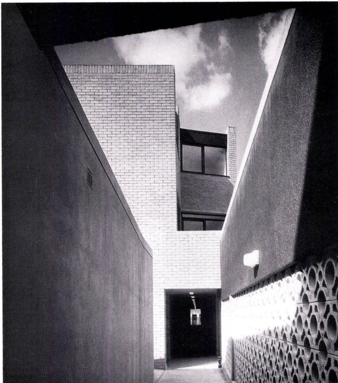
14 Ansicht des Endblockes. Vue du bloc terminal. Elevation view of the terminal block.
