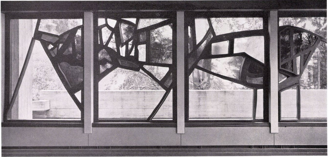
Metallfassaden und Metallfenster
