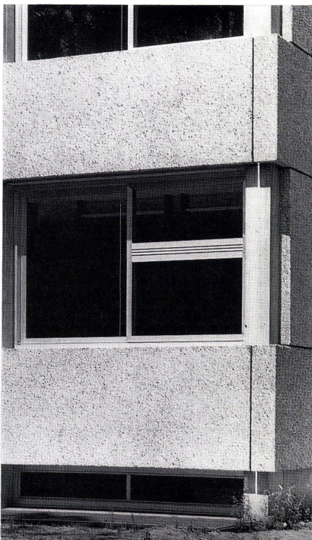
1 Gebäudeecke. Angle de bâtiment. Corner.
