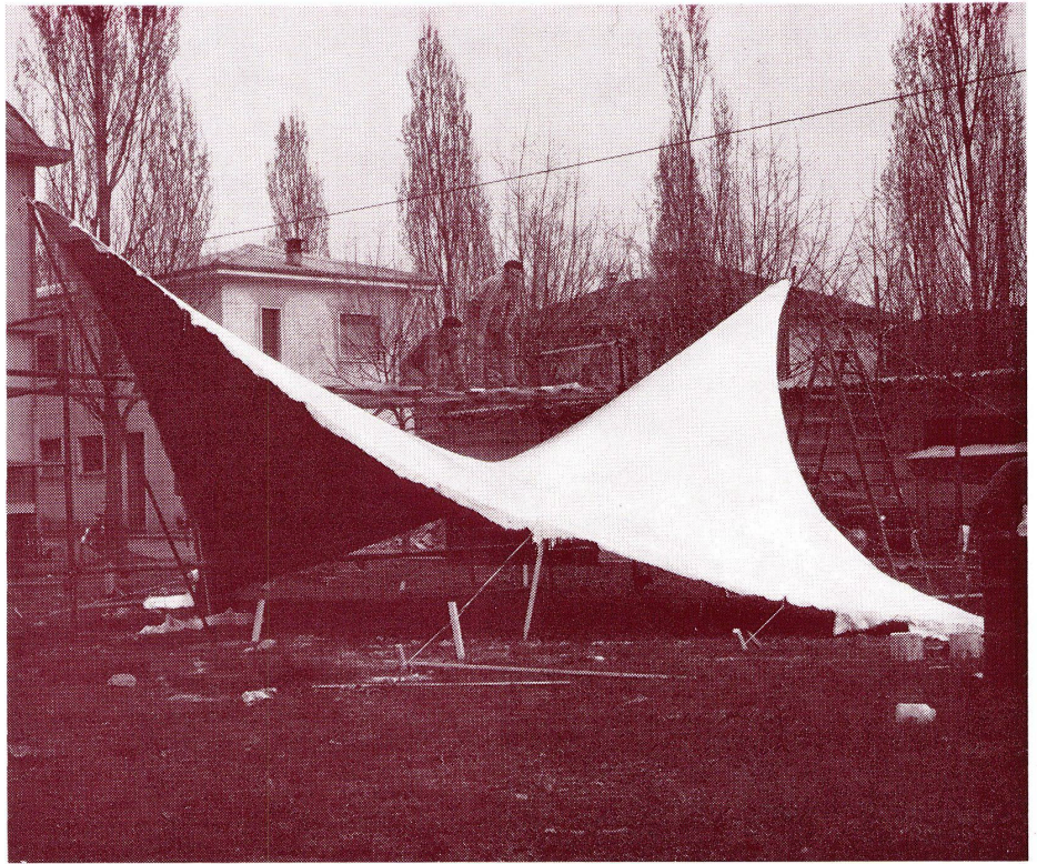
2 Herstellung einer HP-Schale aus glasfaserverstärktem Kunststoff auf einer gedehnten Membran / Fabrication d'une coque HP en plastique stratifié aux fibres de verre sur une membrane étendue / Fabrication of an HP shell of glass-reinforced plastic on a tensed membrane
