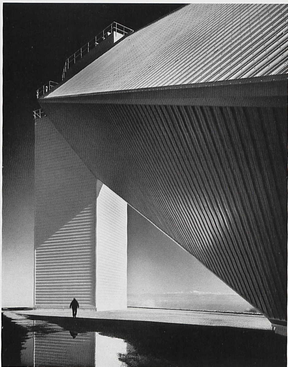
3 Der Heliostat am Ende des Schachtes. Héliostat à l'extrémité du puit. Heliostat at the end of the pit.
