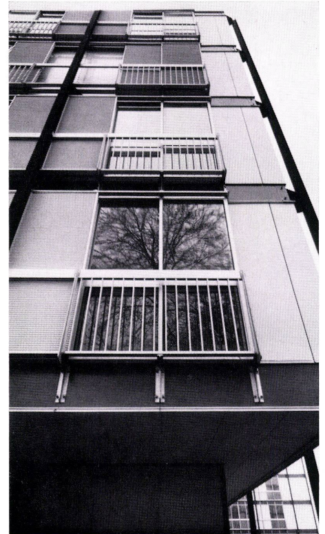
22 Schatten, Reflexe, Flimmern ergänzen die willkürlichen Lädenanordnungen, um verschiedenartige Fassaden durch Standardelemente zu bilden. Ombres, reflets, scintillements complètent les dispositions spontanées des volets pour composer des façades différentes à partir d'éléments identiques. Shadows, reflections, glare complement the different shutter adjustments, in order to create different types of faces with the use of standard elements.
