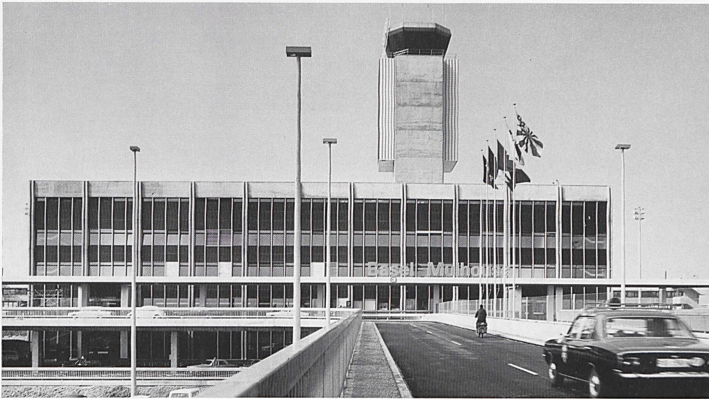
7 Seite der Vorfahrt mit Verkehrswegen von den zugeordneten Parkplätzen. Vue de la rampe d'arrivée avec les circulations des parkings. View of arrival ramp with roadways from parking sites.
