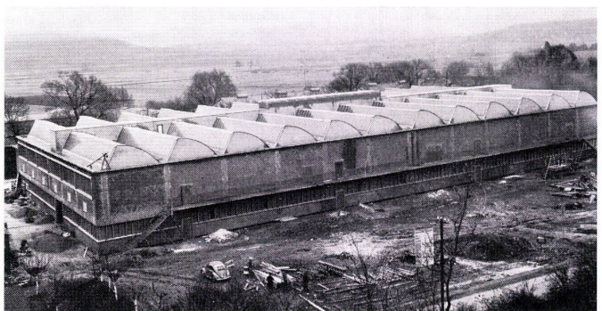
4 Klimaträger im Bau. Zuluftkanal für Druckereisaal.
