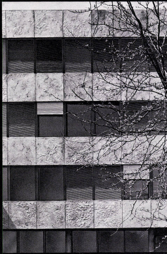
Bürogebäude Bernina, Steckborn
