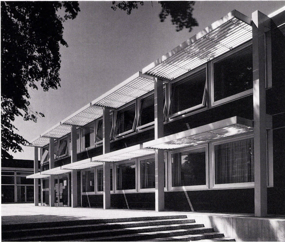
1 Gesamtansicht Eingangsseite. L'ensemble vu côté entrée. Assembly view, entrance side.
