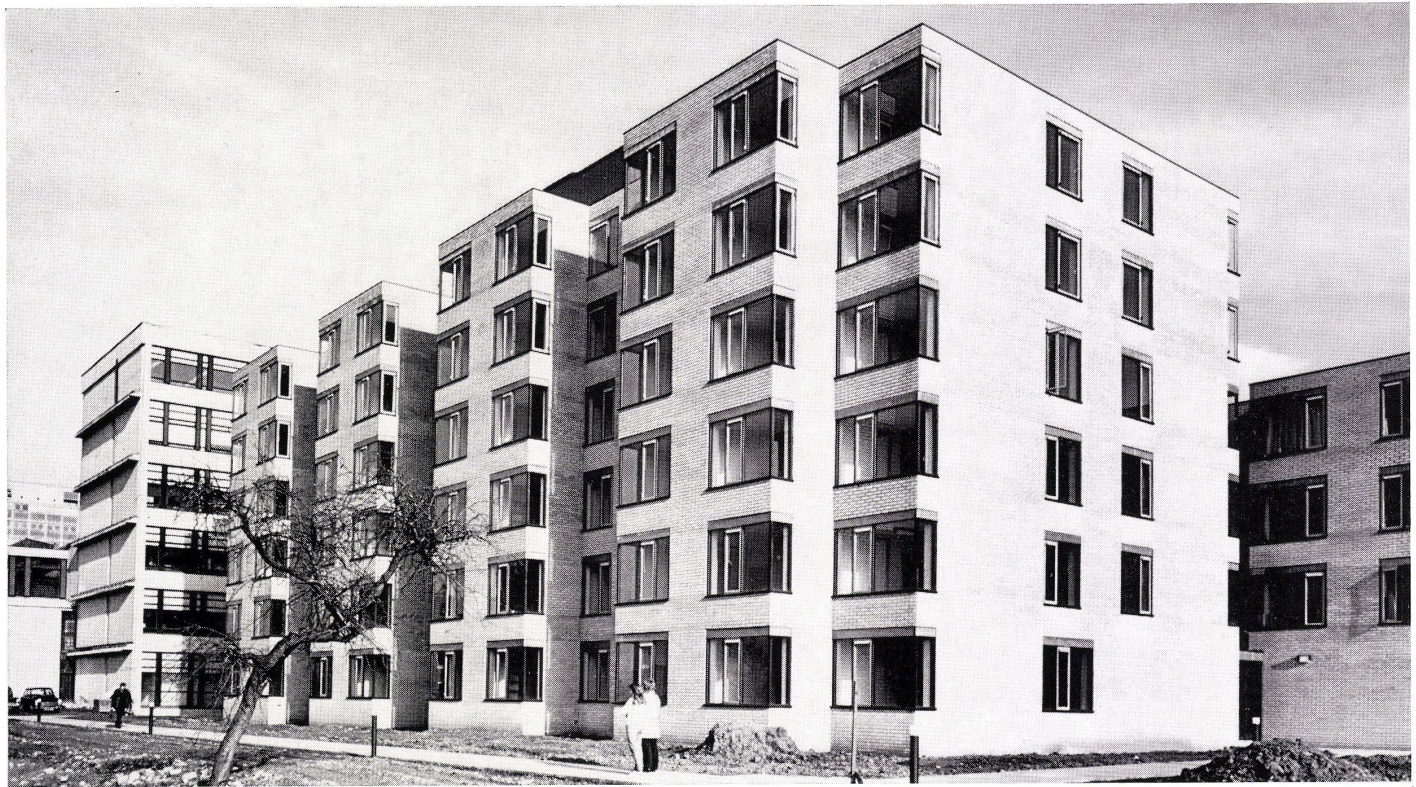
1-3 Gesamtansicht. Vue d'ensemble. Assembly view.
