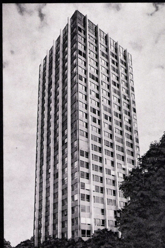
Bürogebäude Sulzer, Winterthur
