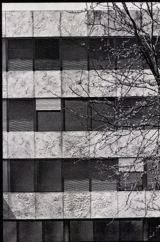
Bürogebäude Bernina, Steckborn
