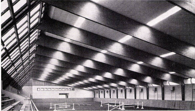
Reithalle von innen.
