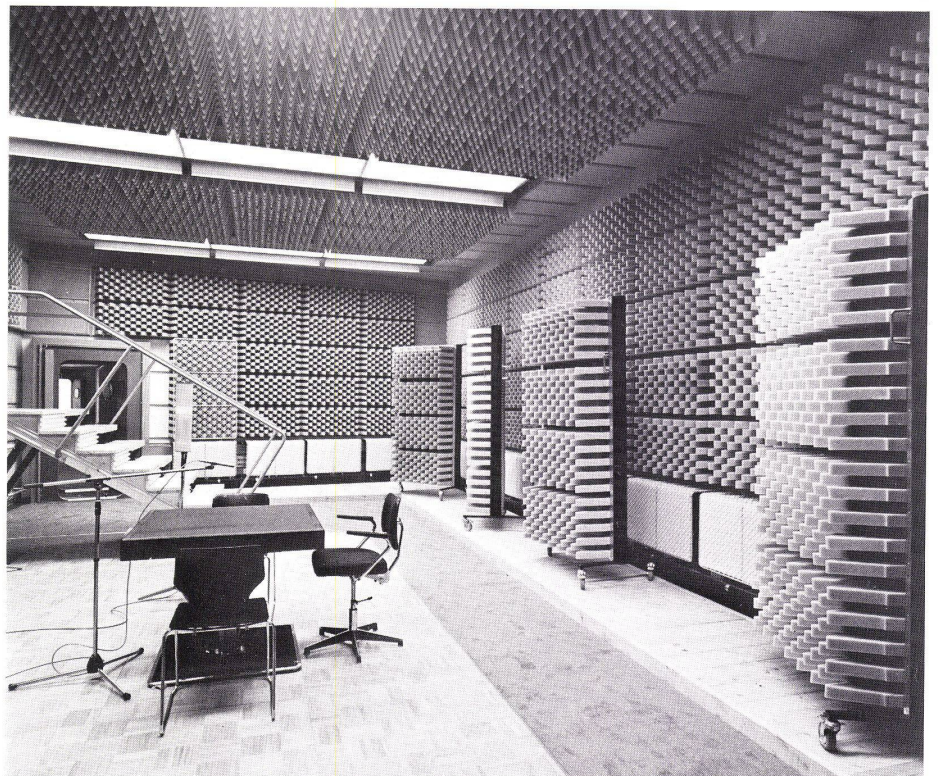
23 Hörsaalstudio mit flexiblen Akustikelementen an den Wänden. Salle d'audition avec parois équipées d'éléments acoustiques flexibles. Audition room with flexible acoustic elements on the walls.
