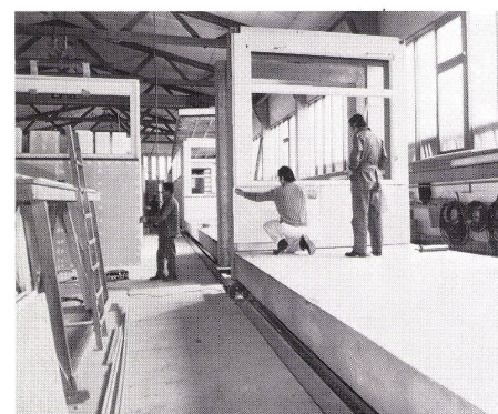
1, 2 Herstellung der Raumzellen in der Fabrik. Fabrication des cellules spatiales en usine. Production of space cells in the factory.
