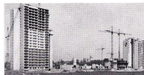
Überbauung Murifeld in Bern. Bauherr: Eisenbahnerwohngenossenschaft Bern, 800 Wohnungen (im Bau).
