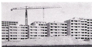
Überbauung La Bourdonette in Renens / VD. Bauherr: Personal-Fürsorgestiftung der Stadt Lausanne, 500 Wohnungen.
