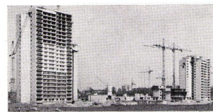
Überbauung Murfeld in Bern. Bauherr: Eisenbahnerwohngenossenschaft Bern, 800 Wohnungen (im Bau).
