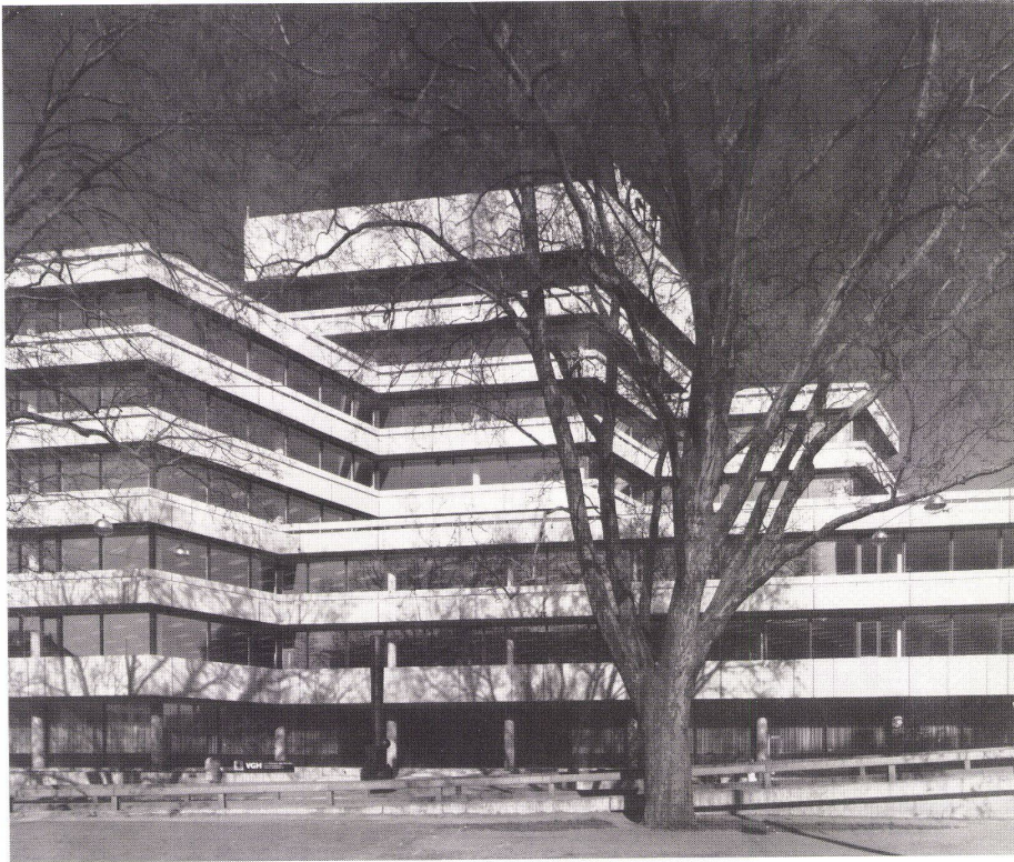
3 Ansicht vom Schiffgraben. Rechts die Auffahrt zur Hochstraße. Plastik vor dem Eingang: Prof. König, München.
