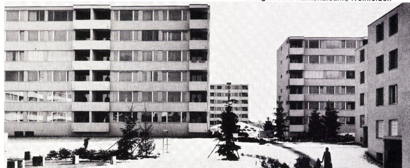
Überbauung Rain, Jona SG
