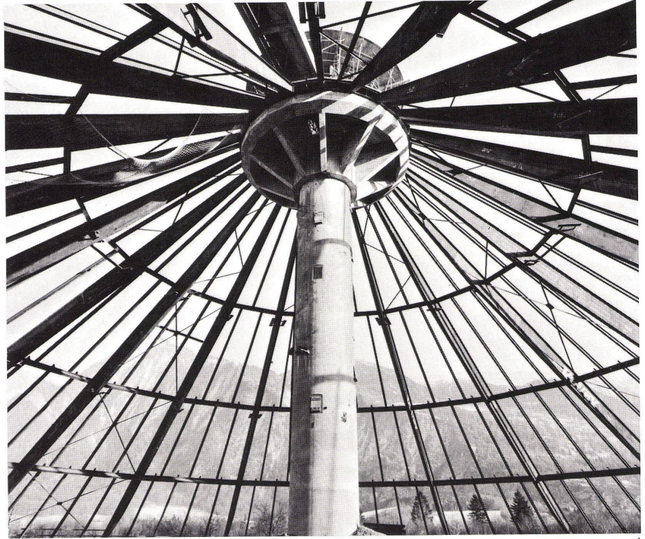
4 Ausschnitt von Turm und Plattform sowie der Tragkonstruktion des Daches.
