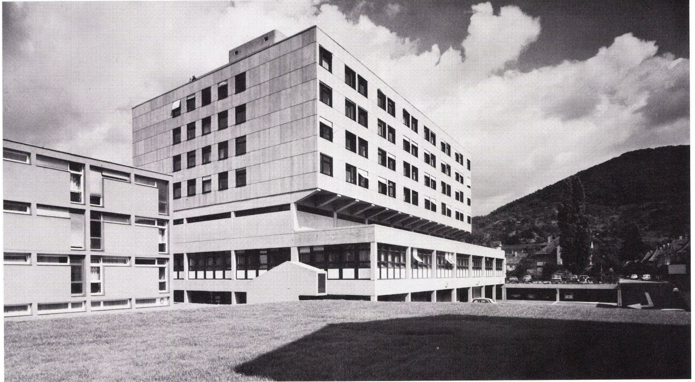
1 Ansicht Eingangsseite. Tragwerk heller Sichtbeton. Fassade Bettenhaus naturgraue Eternitplatten, Fassadenelement Erdgeschoß dunkles Mahagoniholz mit Brüstungen aus Weißbetonit.
