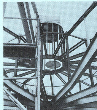
3 Absetzen einer Ringträgerhälfte (Durchmesser 22 m) auf zwei der drei Stahlstützen.
