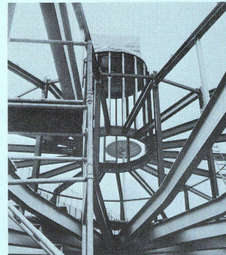
3 Absetzen einer Ringträgerhälfte (Durchmesser 22 m) auf zwei der drei Stahlstützen.
