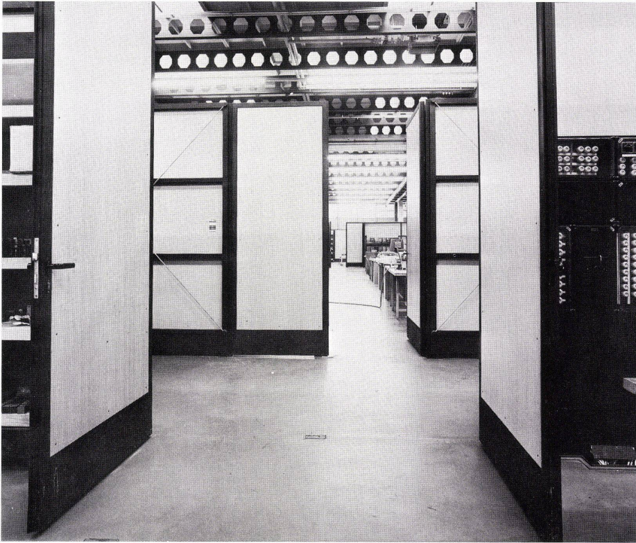
8+9 Ausschnitte vom Erdgeschoß des Hallenbaus. Vues partielles du rez-de-chaussée dans le volume du hall. Details of ground floor of low tract.
