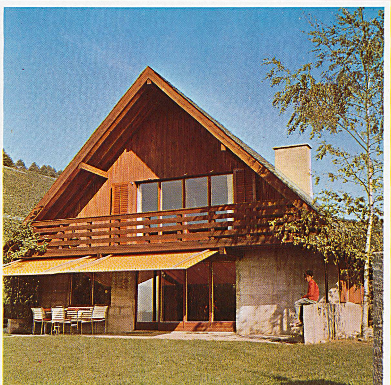
Holzfassade gestrichen mit Color xex umbra.
