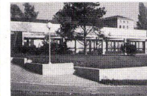
Hôpital de Cery, Lausanne
