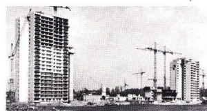
Überbauung Murifeld in Bern. Bauherr: Eisenbahnerwohngenossenschaft Bern. 800 Wohnungen (im Bau).
