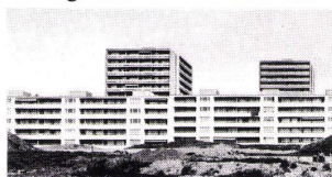
Überbauung Les Bergières in Lausanne. Bauherr: Rentenanstalt Zürich. 250 Wohnungen.
