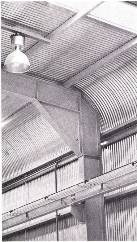
10 Übergang von der Wand zur Decke. Transition entre paroi et plafond. Transition between partition and roof.
