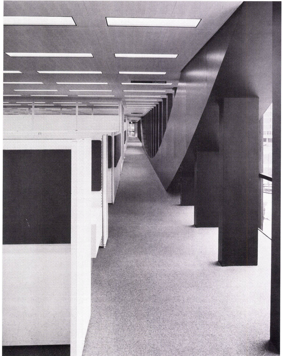
52 Glieder der Hängekonstruktion bestimmen und be- schränken die Grundrißanordnung. Les éléments de la construction suspendue détermi- nent et délimitent l'organisation du plan. Elements of the suspended structure determine and limit the organization of the plan.
