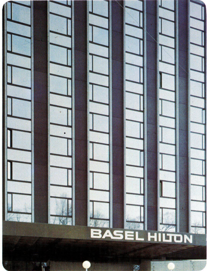
Hotel Basel Hilton, Basel, Schweiz, 1975 INFRASTOP-Silber 36/33 T – Arch. Rickenbacher+Wegmann, Basel
