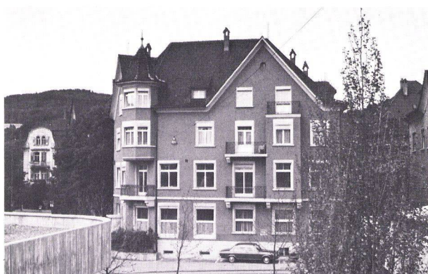
Kt. Aargau: Nachträglicher Einbau von ALUMBRA-Rolläden
