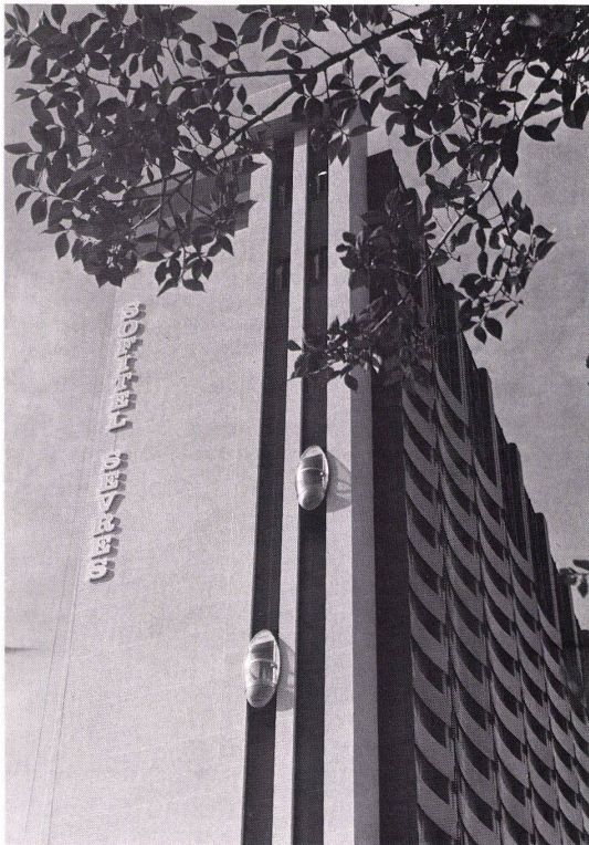
Otis Außenaufzüge Das Hotel «Sofitel» in Sèvres (Frankreich)
