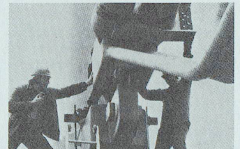
Die Details geben einen Eindruck von den Dimensionen des Baus. Die auskragenden Trägereile wurden bei Krupp, Rheinhausen, hergestellt, da man nur hier in der Lage war, sie innerhalb der im Projekt vorgesehenen Kostenlimits anzufertigen. Die senkrechten Stützen, die mit 85 cm Durchmesser aus drei Stücken von 7 m, 21 m und 23 m zusammengesetzt sind, wurden bei Fumel in Pont-à-Mousson gegossen.
