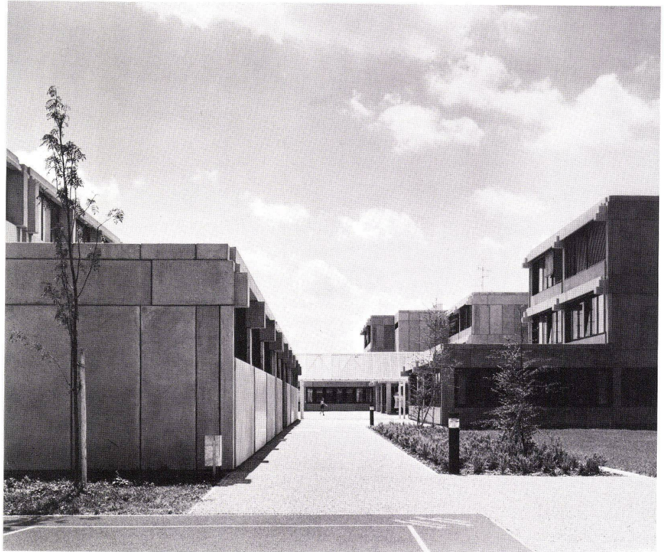
17 Verbindungsgang zwischen Sporthalle (rechts) und Hauptgebäude. Couloir de liaison entre la halle omnisport (à droite) et le volume principal. Connecting corridor between gymnasium (right) and main building.
