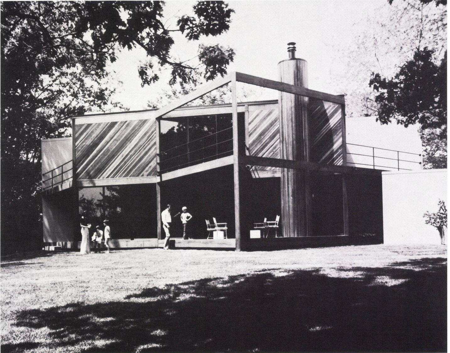
Dieses Experimentierhaus stellt einen Versuch dar, fabrikgefertigte Kernelemente, die alle Naßräume, wie Küche, Bad und WC sowie Heizung und Lüftung enthalten, mit vorgefertigten Holzelementen zu dem Wohn- und Schlafbereich zu verbinden. Die Kernelemente sind 8 × 12 ft. groß, werden von der Fabrik geliefert und wie Trailer zusammengesetzt. Für die Anordnung des Wohn- und Schlafbereiches sind viele Variationen möglich, das Grundmodul beträgt 12 × 12 ft.
