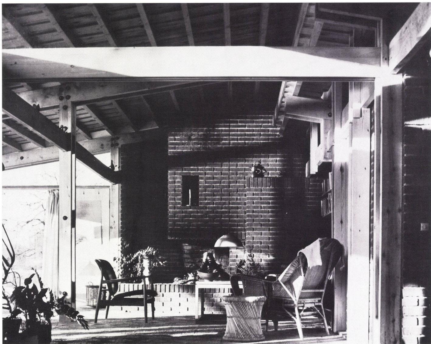
Das langgestreckte Haus ist auf einem Achsmaß von 3 m aufgebaut. Vor- und Rücksprünge, so am Eingangsbereich des Büros und im Anschluß an den Wohnraum, lockern die straffe Form auf. Die Mauerwerksteile bestehen aus braunen Ziegelsteinen, die im Raum sichtbare Holzkonstruktion ist aus heller Kiefer. Der architektonische Charakter des Hauses wird durch die Materialien, ihre Anordnung und die sorgfältige handwerkliche Verarbeitung bestimmt.
